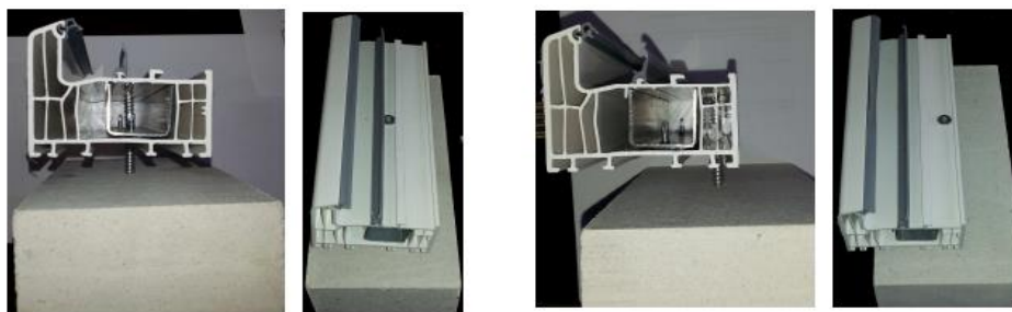
Изображения 1 и 2 Вариант 1: крепление через главную камеру и армирующий профиль
