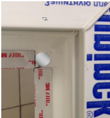
Фото 9. Нанесение силикона.
