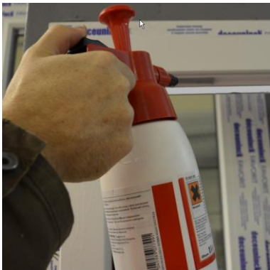
Фото 10. Удаление защитной пленки и нанесение мыльного раствора.
