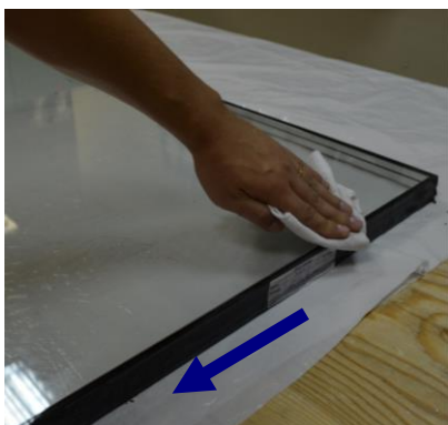
Фото 8. Продольная протирка края стеклопакета.
