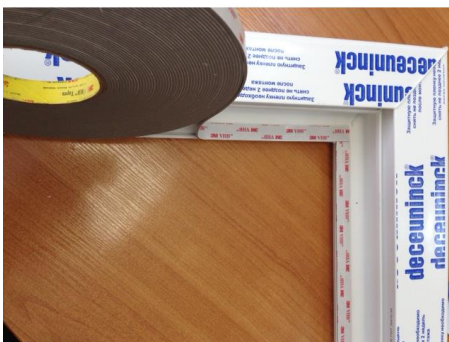
Фото 13. Нанесение новой ленты
