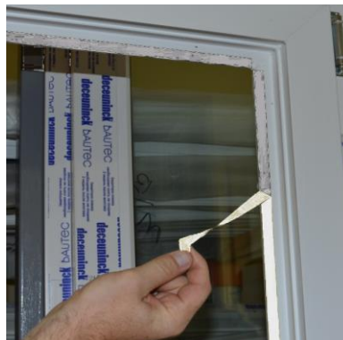
Фото 10. Удаление защитной пленки и нанесение мыльного раствора.
